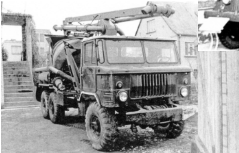
Раствороподатчик на шасси ЗиЛ-157К с кабиной от ГАЗ-66. Фото из архива Л. Сусливичюса
