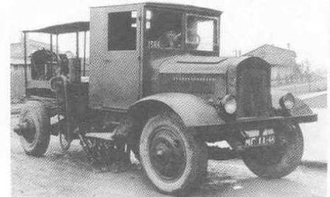
Машина для склипа льда на базе ЯГ-6. Первоначальный вид этого грузовика в 1930-х гг.
