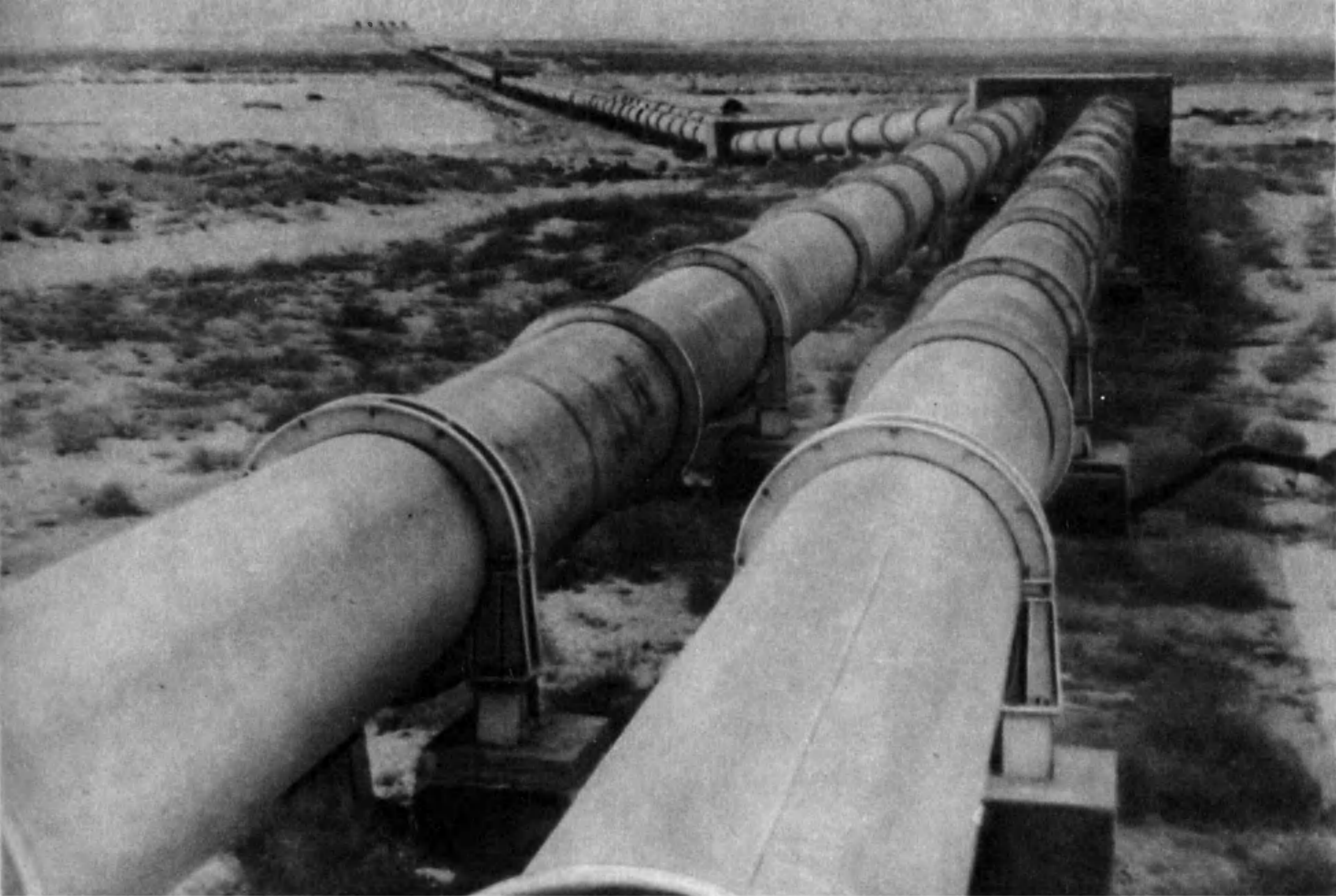
Город Шевченко Гурьевской области. По этим трубам соленая вода из Каспийского моря поступает на опреснительную станцию.
